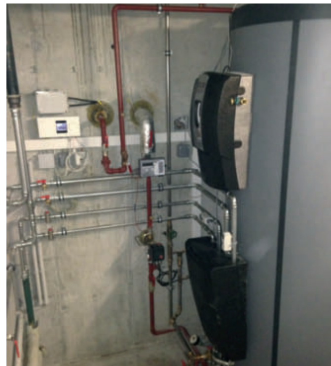
Die Geothermie-Fernwärme St. Martin nutzt 93 °C heißes Thermalwasser (großes Bild). Der Link3-Fernwärmespeicher (oben) mit integriertem Fernwärmeregister senkt die Rücklauftemperatur ins Netz um 13 °C.
