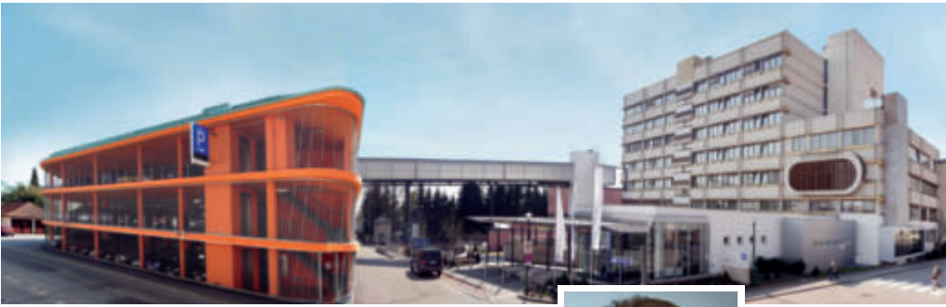
Im LKH Schärding sorgt ein LINK3-Speicher für energieeffiziente Wärmerückgewinnung ebenso wie für ÖNORM-konforme Legionellensicherheit.
