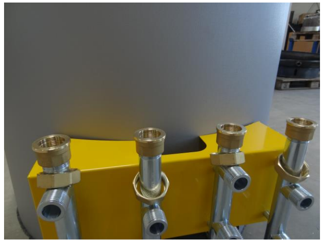
aufdichten der Übergänge 1" auf 6/4"
