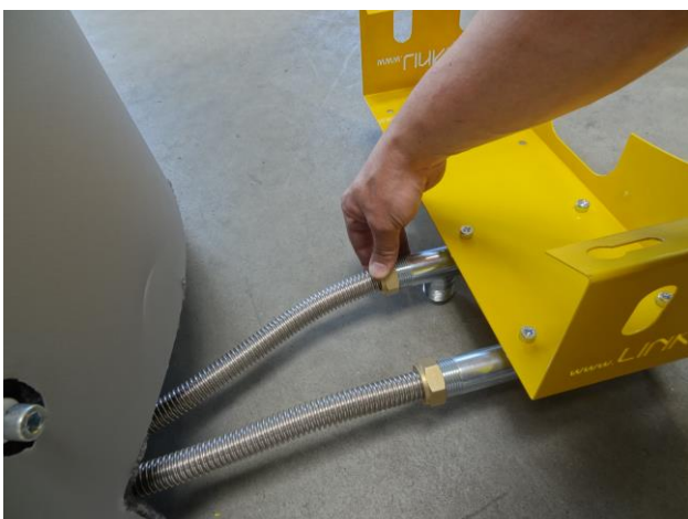
Variante: Wellrohrverbinder mit vormontierter Montageplatte verbinden...
